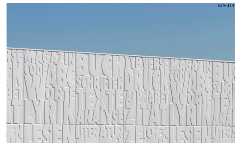
„Der Baukörper ist vollständig mit weiß eloxierten Metallplatten verkleidet, die reliefartig Wörter erkennen lassen. So ist die Funktion als ‚Bücherturm‘ auch von außen zu erkennen“, sagt Anke Winsmann von der SuUB.
